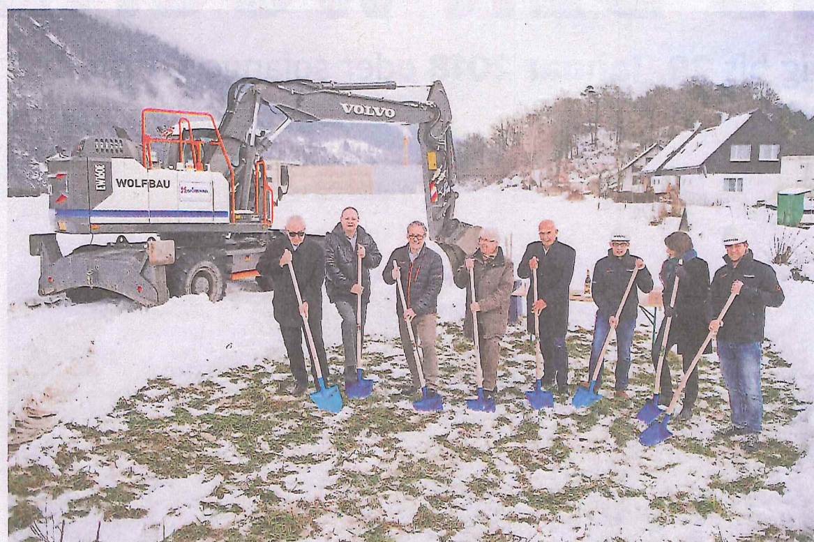
Spatenstich des Hofstättle-Quartiers in Domat/Ems. Hier sollen 26 Wohnhäuser entstehen, die zum Teil ab April 2019 bezugsbereit sein sollen. (FOTO OLIVIA ITEM)
