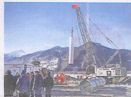
Malans und Landquart bauen auf der Panxwiese ein gemeinsames Pumpwerk. (FOTO OLIVIA ITEM)
